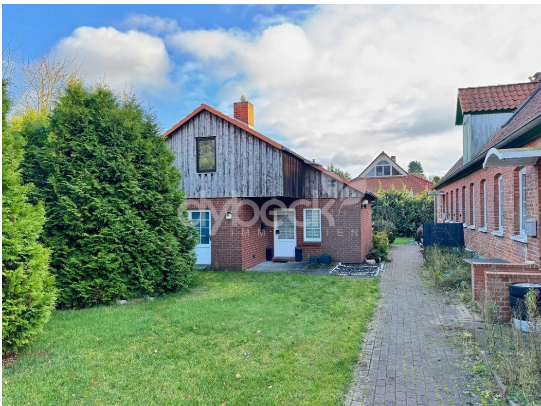
Zuwegung ehemaliges Stallgebäude links
