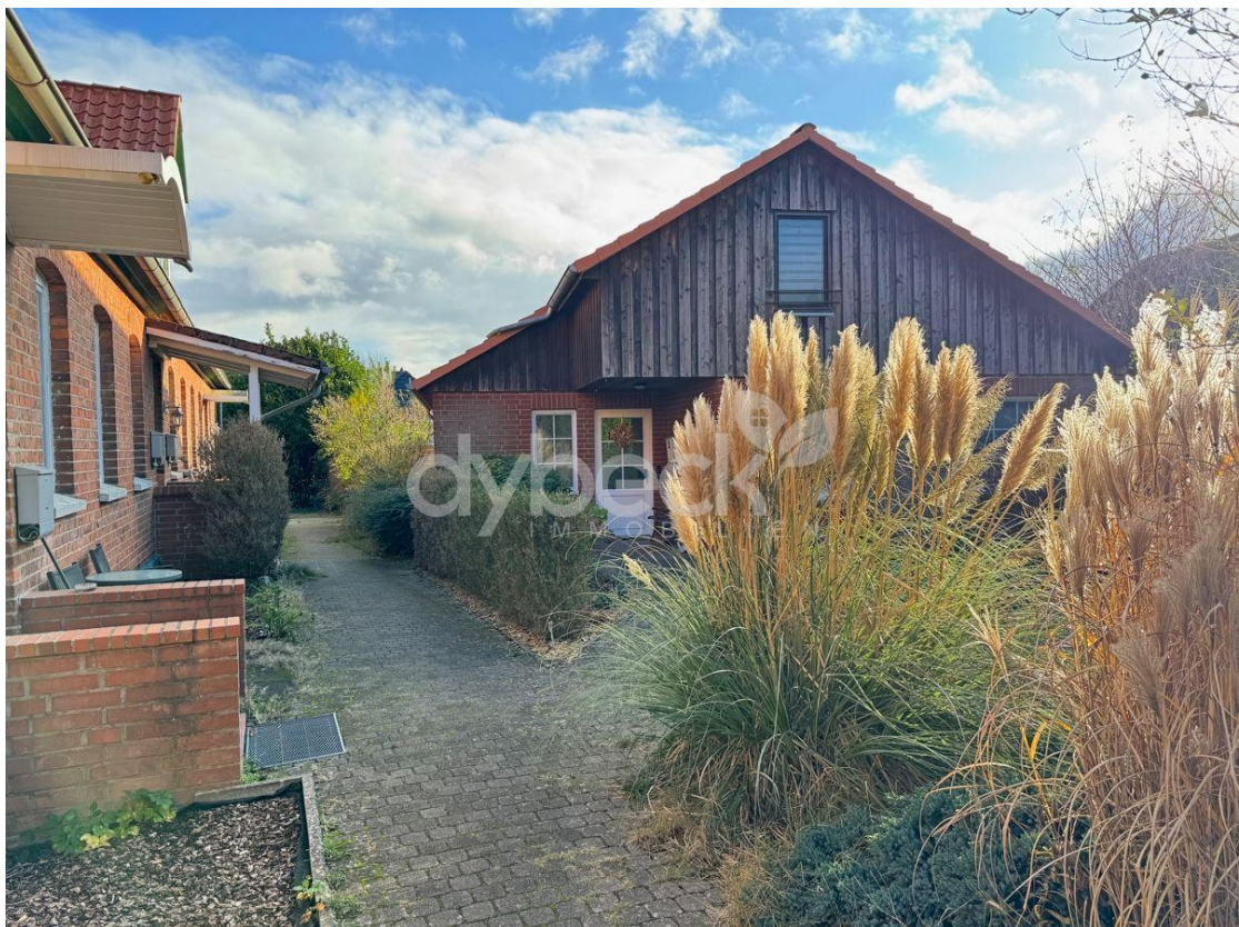
Zuwegung ehemaliges Stallgebäude rechts
