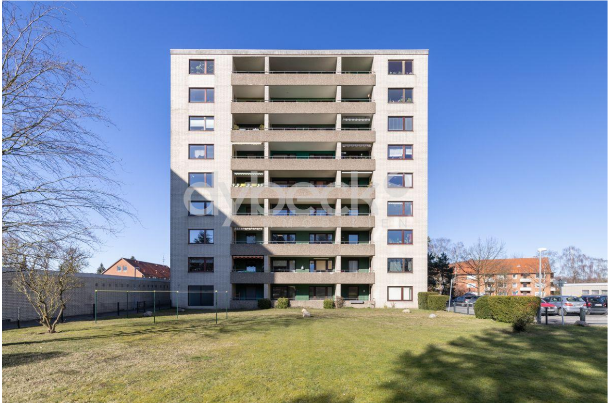
Außenansicht baugleiches Gebäude
